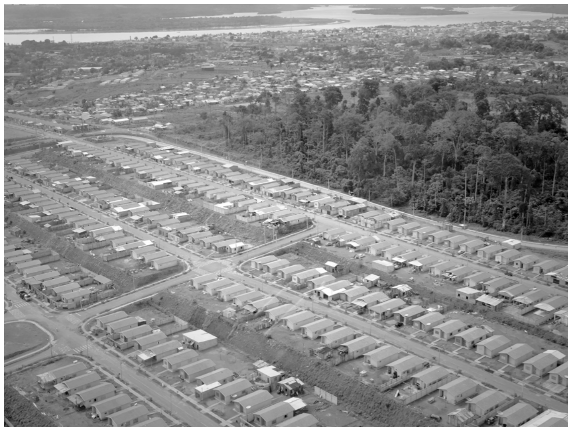
Figura 6. Reassentamento Urbano Coletivo (RUC). Fonte: Ministério do Planejamento (PAC), 2016.
