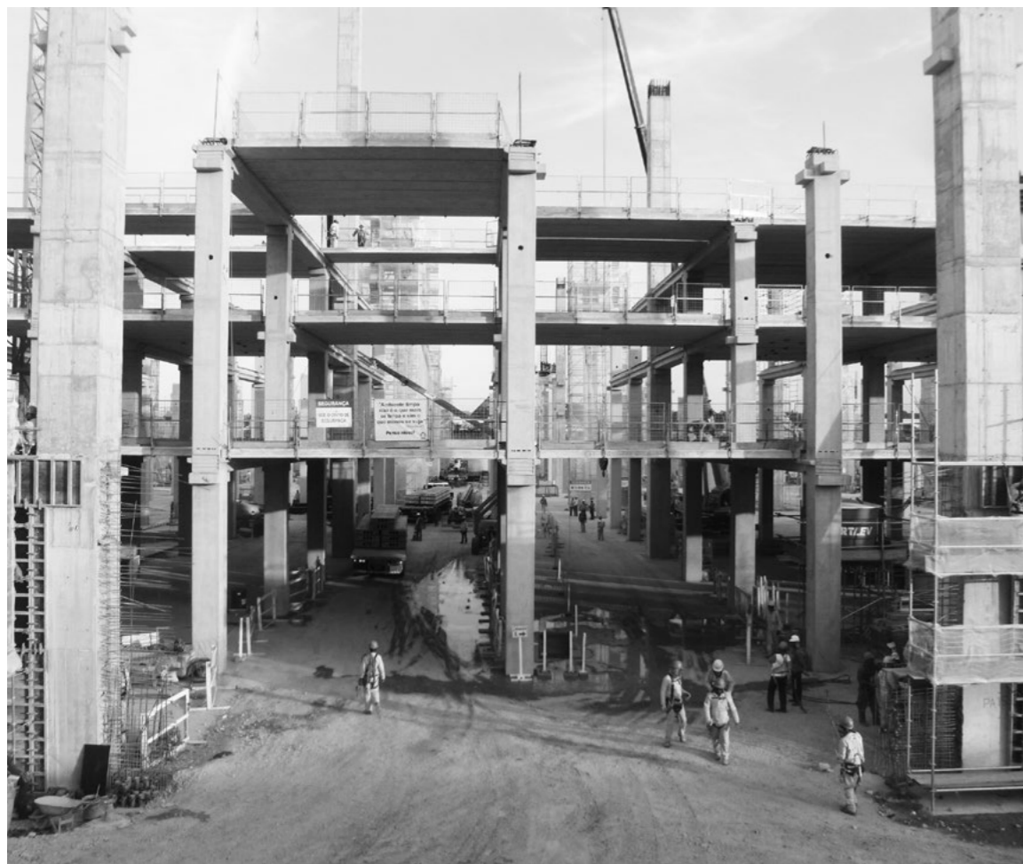
Figura 5. Construção do Terminal 3. Fonte: foto de Andrei Almeida, 2013.
