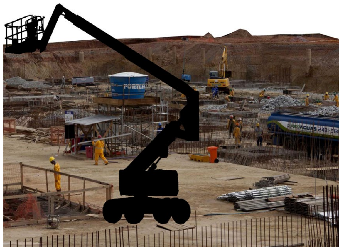
Canteiro de Obra. Fonte: montagem da autora, 2017
