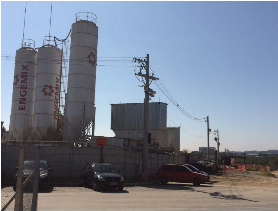
(Imagem3 - Central de concreto e entrada do canteiro)
