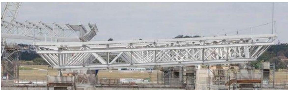
Figura 41. Detalhe do apoio da cobertura sobre os pilares no canteiro de obra. Fonte: Marcelo Scandarole, 2013.
