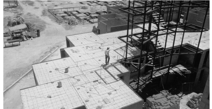
Edifícios do COPROMO em construção. Acervo Usina CTAH.
